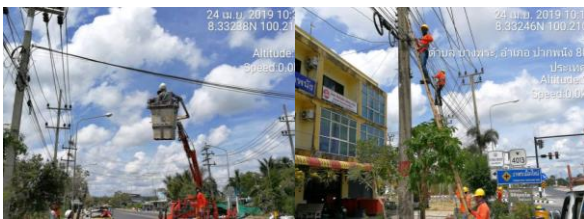
วันที่ 24 เมษายน 2563 เวลา 9.00น.การไฟฟ้าส่วนภูมิภาคอำเภอปากพนัง พร้อมด้วยผู้ประกอบการด้านสื่อสาร ร่วมจัดระเบียบสายและอุปกรณ์สื่อสารโทรคมนาคมบนเสาไฟฟ้าของการไฟฟ้าส่วนภูมิภาค บริเวณคอสะพานปากพนังฝั่งตะวันออก อำเภอปากพนัง จังหวัดนครศรีธรรมราช รวมระยะทาง 1.5 กิโลเมตร เพื่อเป็นการสร้างภูมิทัศน์ให้บ้านเมืองสวยงาม และสร้างความมั่นคงด้านการใช้ไฟฟ้าของประชาชนผู้ใช้ไฟ
