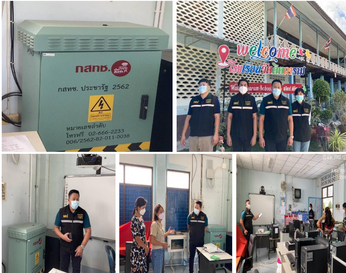
รูปการตรวจเยี่ยมและทดสอบการใช้งานจริง จุดติดตั้ง Wi-Fi โรงเรียนวัดดัดการาม หมู่ 2 ต. ท่าอยู่ อ.ตะกั่วทุ่ง จ. พังงา
