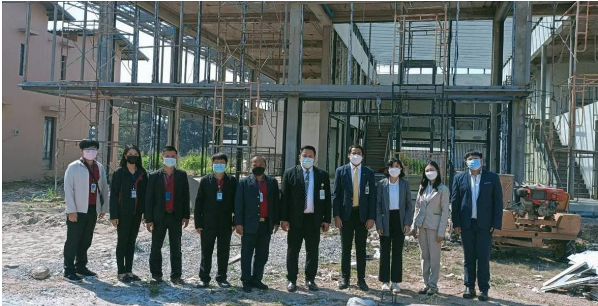
รูปการลงพื้นที่ตรวจติดตามความคืบหน้าการก่อสร้างอาคารสำนักงาน กสทช. เขต 34 เชียงราย
