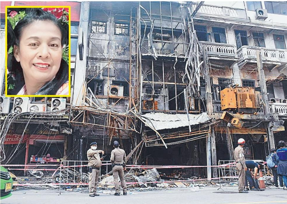
▲ ล้อมคอก เจ้าหน้าที่หลายหน่วยแห่ตรวจสอบเหตุเพลิงไหม้ตึกแถวย่านสำเพ็ง หลังหม้อแปลงระเบิดไฟลุกลามหลายคูหา ทำ น.ส.จิราพัชร สุ่มมาตร (ภาพเล็ก) และคนงานชาวเขมรเสียชีวิตคาถองเพลิง เร่งปรับปรุงหม้อแปลงเก่าทั่วกรุง.
