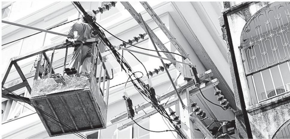
การบูรณาการของ เมืองพัทยา ร่วมกับการไฟฟ้าส่วนภูมิภาค และหน่วยงานต่างๆ ดำเนินโครงการนำสายไฟฟ้าลงดิน เพื่อจัดระเบียบสายไฟฟ้า รองรับเมืองท่องเที่ยวอัจฉริยะควบคู่กับการเป็นเมืองน่าอยู่.
