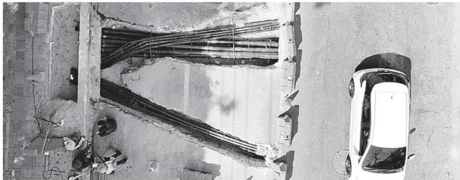
ภาพมุมสูงงานก่อสร้างระบบจำหน่ายใต้ดินงานระบบจำหน่ายแรงสูงเหนือดินพร้อมOverhead Ground Wire การจัดระเบียบสายไฟฟ้า และงานรองรับการสื่อสารใน 9 เส้นทางหลัก ระยะทาง 20 กิโลเมตร.
