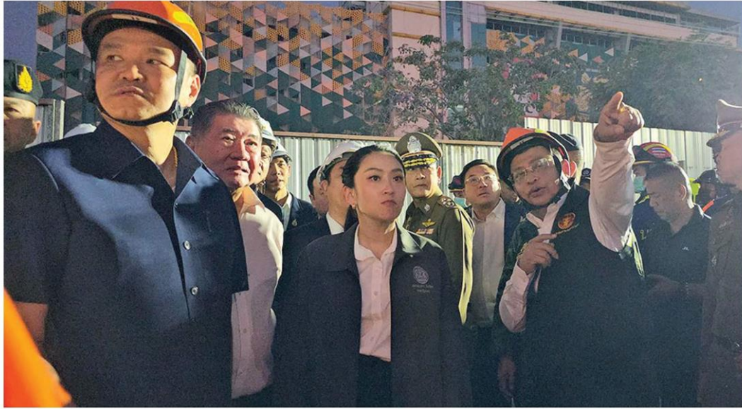
ลงพื้นที่ - น.ส.แพทองธาร ชินวัตร นายกรัฐมนตรี พร้อมนายภูมิธรรม เวชยชัย รองนายกรัฐมนตรี และ รว.กลาโหม นายอนุทิน ชาญวีรกูล รองนายกรัฐมนตรี และ รว.มหาดไทย ลงพื้นที่ที่ตรวจจุดเกิดเหตุก่อสร้างอาคารที่ทำการสำนักงานการตรวจเงินแผ่นดินแห่งใหม่ ย่านจตุจักร ที่ถล่มหลังเหตุแผ่นดินไหว เมื่อวันที่ 28 มีนาคม
