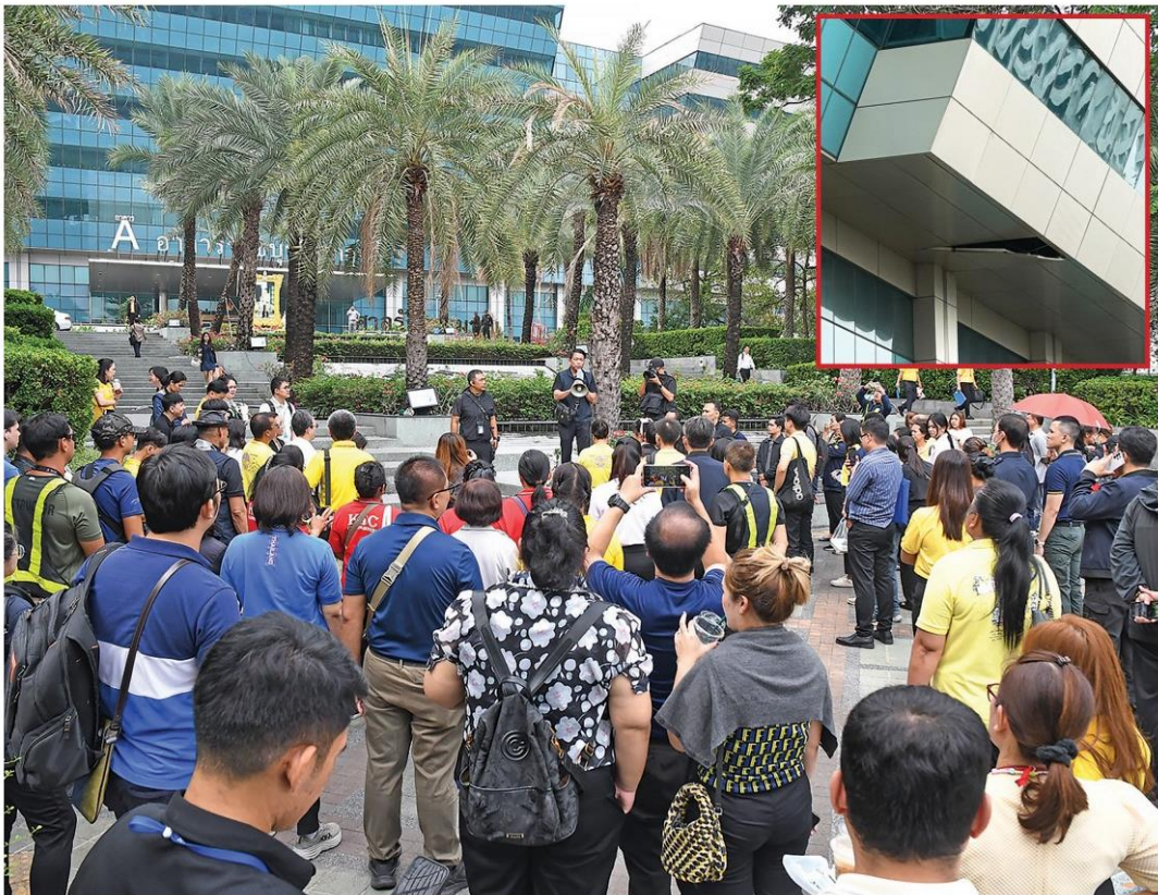
🏠 แตกตื่น - เจ้าหน้าที่และประชาชนที่มาติดต่อราชการแตกตื่นหนีออกจากอาคาร เอ ภายในศูนย์ราชการ แจ้งวัฒนะ เขตหลักสี่ กทม. หลังมีการแจ้งอาคารร้าวจากแผ่นดินไหว ต่อมาเมื่อตรวจสอบแล้วปลอดภัยจึงกลับเข้าทำงานตามปกติ เมื่อวันที่ 31 มี.ค.
