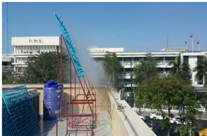
ติดตั้งบन्दาดฟ้าตึกสันติไมตรี
