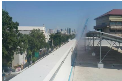
ติดตั้งบन्दาดฟ้าอาคาร ๔๑
