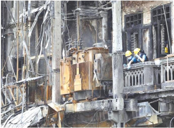
สาเหตุเบื้องต้นอาจเกิดจากหม้อแปลงไฟฟ้าระเบิด โดยมีสายสื่อสารรุงรังบนเสาได้หม้อแปลงเป็นหนึ่งในเรื่องเพลิง ทำให้ไฟไหม้ลามเข้าอาคารและไปบริเวณใกล้เคียง
