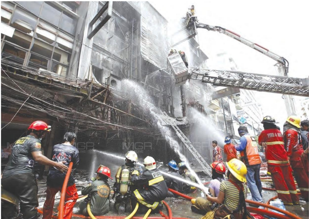
เหตุการณ์ไฟไหม้สำเพ็ง เมื่อวันที่ 26 มิ.ย. 2565 พบว่ามีอาคารพาณิชย์ได้รับความเสียหาย 6 คูหา รถยนต์เสียหาย 1 คัน มีผู้เสียชีวิต 2 ราย มูลค่าความเสียหายไม่ต่ำกว่า 30 ล้านบาท
